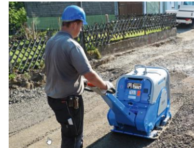
Tunnelausbruch: eingebaut und verdichtet
