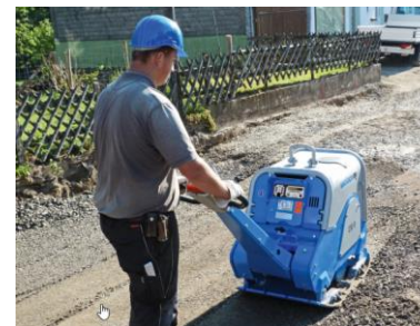
Tunnelausbruch: eingebaut und verdichtet
