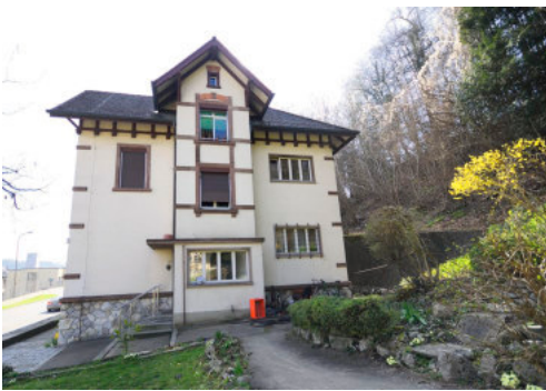
0695 Ansicht der Nordfassade
