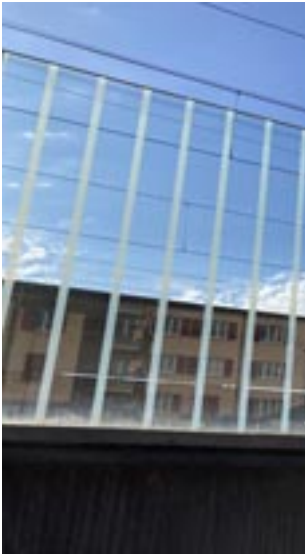
Lärmschutzwände am Bahnhof Effretikon: Die milchigen Längsstreifen machen die Glasscheiben für Vögel sichtbar.
