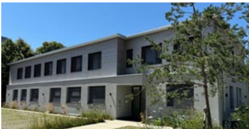
Das Gebäude für die Zusammenlegung der Arbeitsplätze an der Sophie-Guyer-Strasse 9 in Pfäffikon
