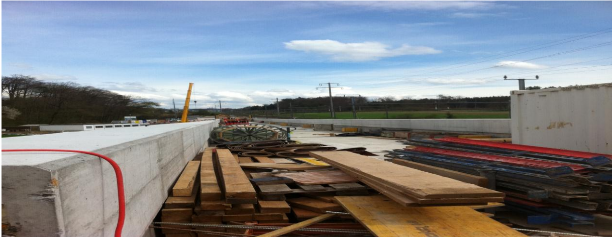
Foto IX: Die aktuelle Baustelle „Hürlistein“ in Tagelswangen, welche demnächst nahtlos durch jene für den Bau eines 4. Gleises abgelöst wird.
