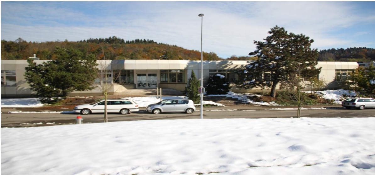
Foto IV: Neues Zuhause für die Kindertagesstätte. Die Kindertagesstätte ZicZac hat im ehemaligen „Adidas-Haus“ einen idealen neuen Standort gefunden.
